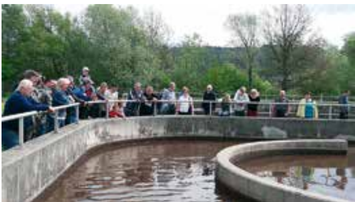
Besichtigung der Klärbecken.
